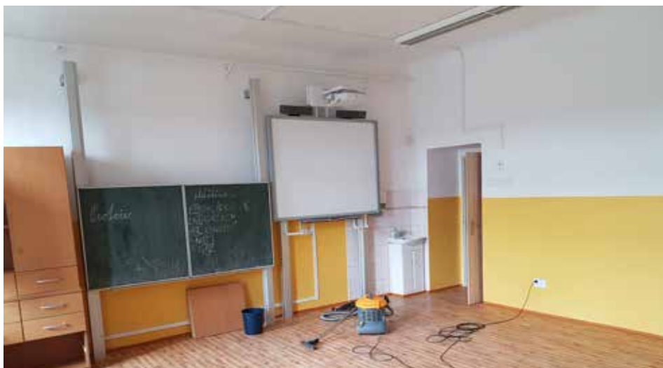
Ve spodních třídách dělníci oškrábali omítku, která pamatovala ještě válku a stěny nově vymalovali. Na podlahách je nové PVC a nová je také elektroinstalace.
