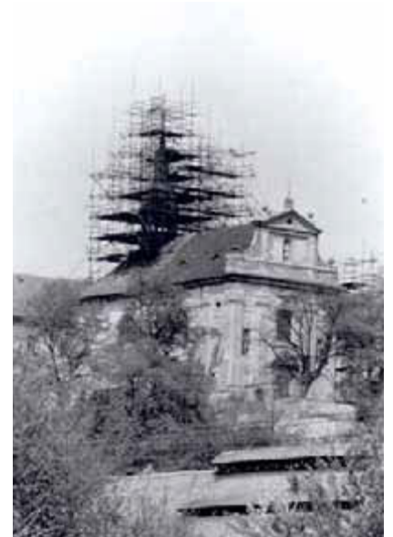
Oprava věže roku 1984
